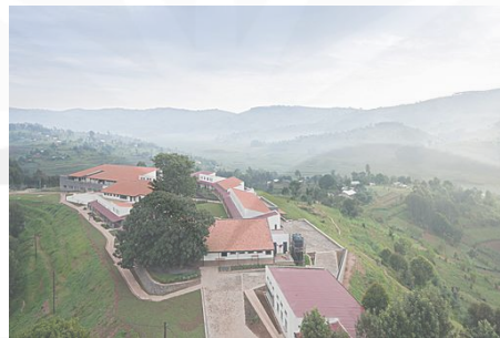
Gambar 2.2 Tampak secara keseluruhan Butaro Hospital
