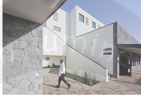
Gambar 2.5 Taman kolam menuju area bangunan tingkat bawah
