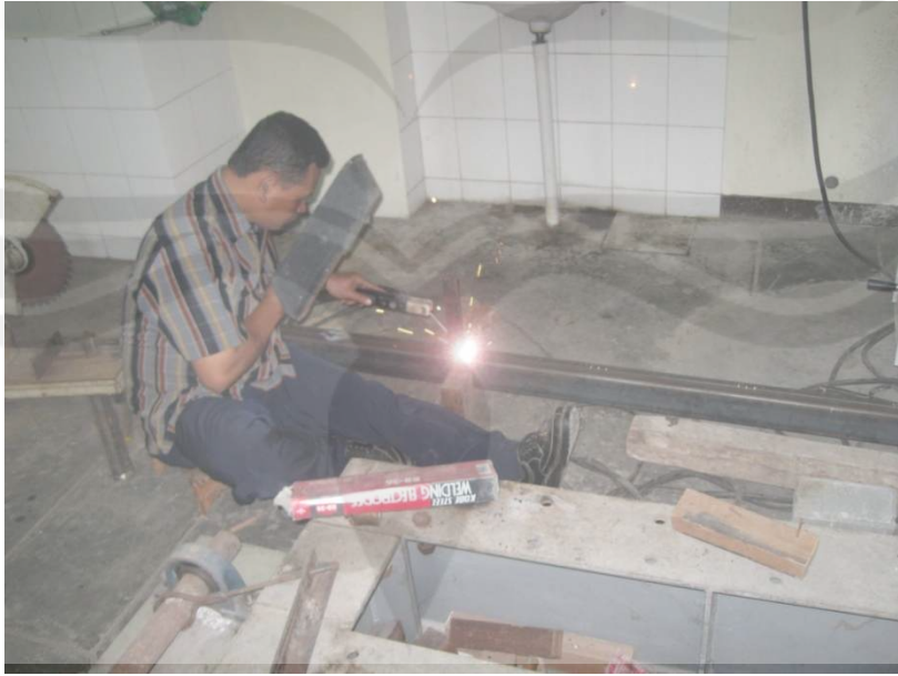
Proses Pengelasan Kolom Baja Profil C Gabungan
