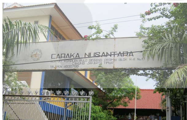
Gambar 2.9 Tampak Depan SMK Caraka Nusantara Jakarta
