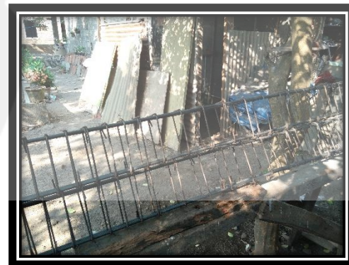
Tulangan yang Sudah Dirakit
