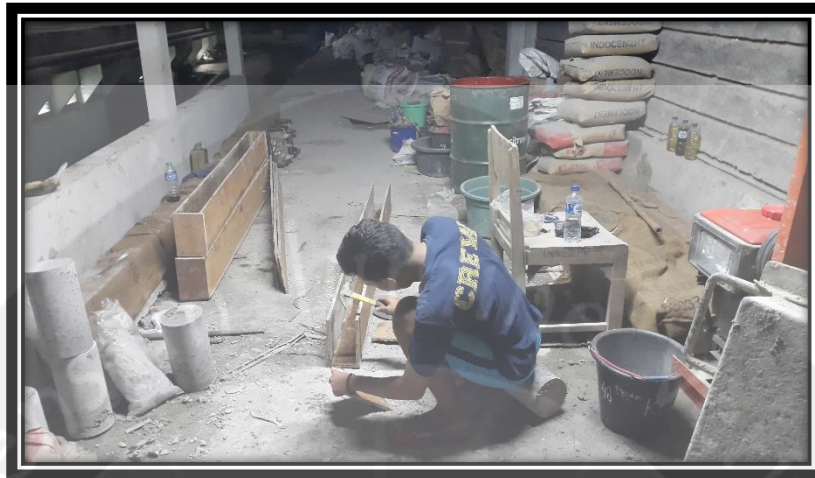
Pembuatan Bekisting Balok
