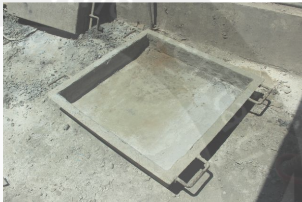
Tempat adukan beton
