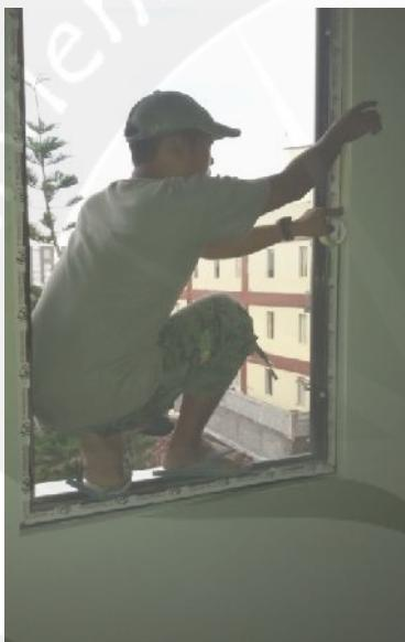
Pemasangan isolasi kertas di sepanjang pinggir dinding *opening*, hal ini dimaksudkan agar *sealant* terlihat rapi dan tidak mengotori *opening* maupun kusen uPVC sendiri
