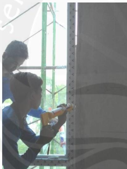
Kusen yang sudah terpasang benar, dilengkapi dengan pemberian *sealant* menggunakan alat dengan maksud menghalangi air masuk ke dalam.
