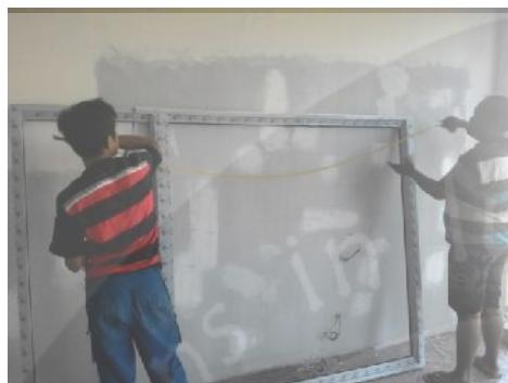
Pengukuran kusen aluminium menggunakan meteran untuk memastikan ukuran agar sesuai *opening*.
