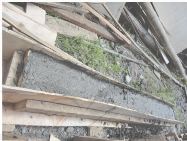
Pengecoran Benda Uji
