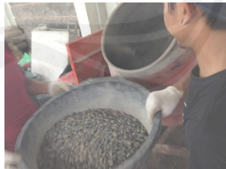
12. Proses Pembuatan Adukan Beton
