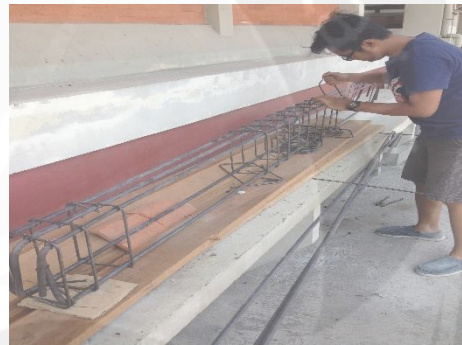
10. Proses Perakitan Tulangan
