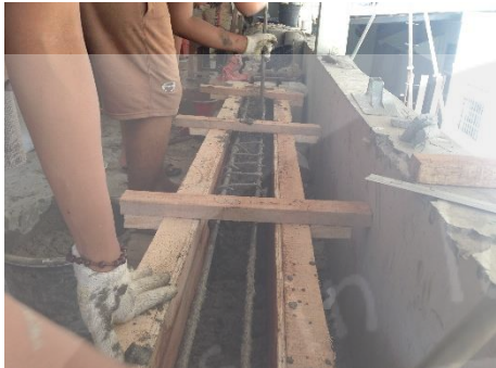
13. Proses Pemadatan Adukan dalam Bekisting Balok
