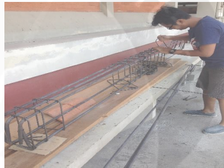
10. Proses Perakitan Tulangan
