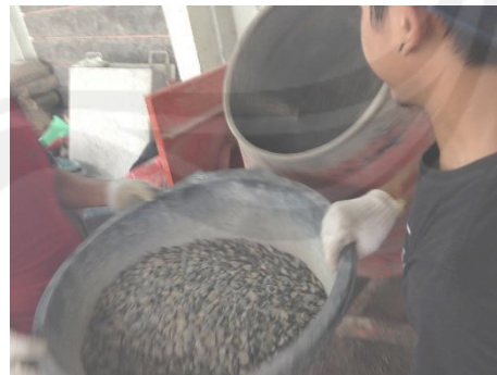
12. Proses Pembuatan Adukan Beton
