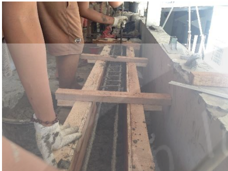
13. Proses Pemasangan Adukan dalam Bekisting Balok
