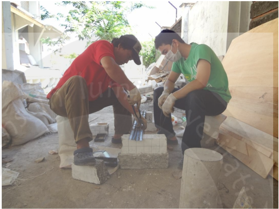
Gambar 11. Perakitan Tulangan Baja
