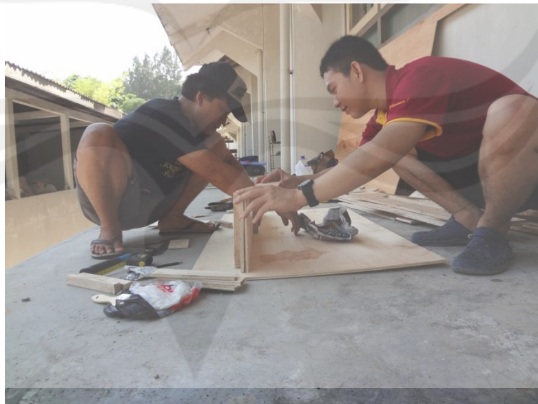
Gambar 8. Pembuatan Bekesting
