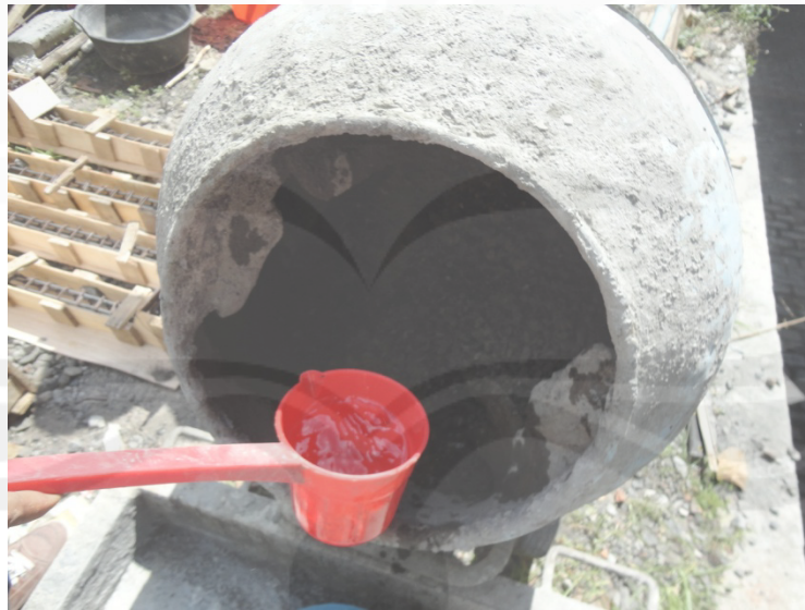
Pengecoran Benda Uji
