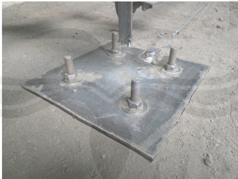
Keruntuhan model uji pada kelompok tiang
