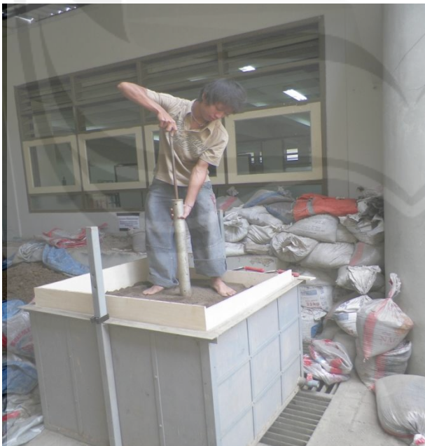
Pemadatan tanah pasir
