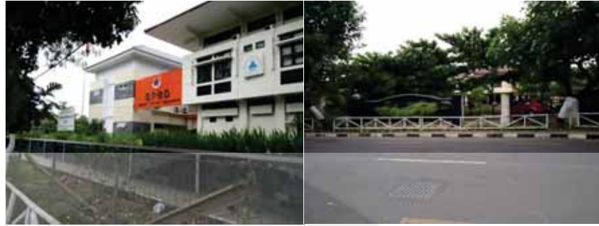
Gambar 3.26 Kantor BPBD dan Kantor PIP2B
