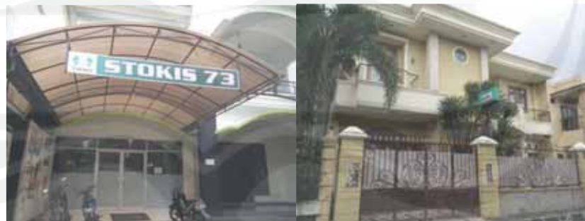
Gambar 3.21 Rumah usaha Sumber: Dokumentasi Penulis, 2015
