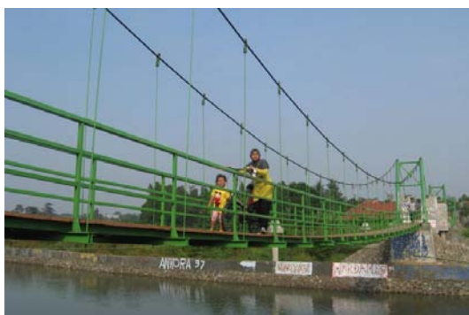
Gambar 2.15 : Jembatan gantung menuju pulau buatan
