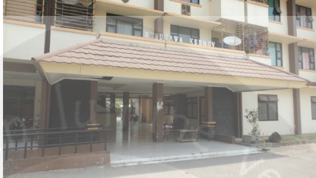
Gambar 3. 24 Pintu Masuk Rusunawa Kerhoff
