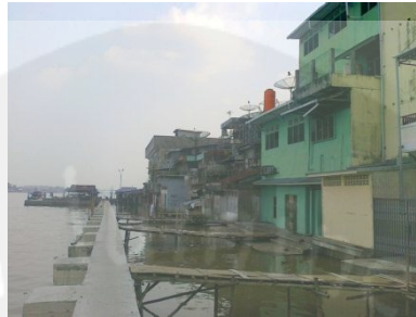
Gambar 1.2. Turap yang telah terbangun di kawasan perencanaan WFC Sumber : Google.com
