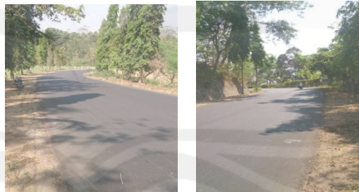
Gambar 3.19 Kondisi Infrastruktur Jalan Menuju Tapak
